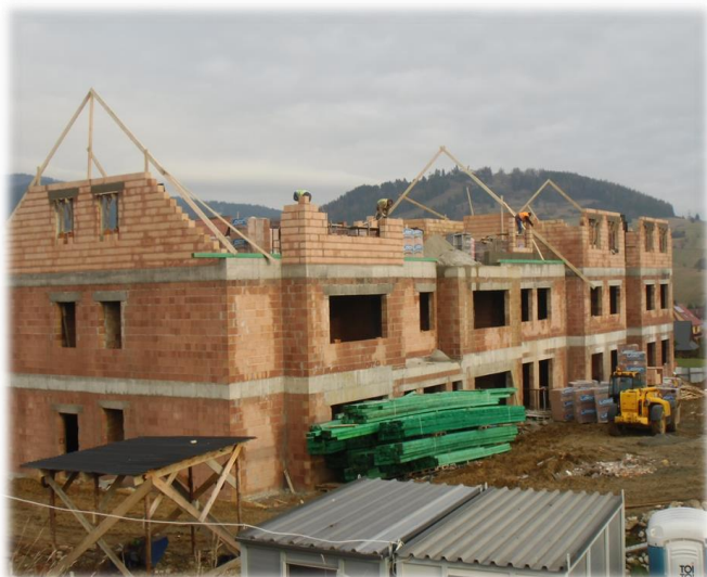
Budowa Szkoły w Kluszkowcach
